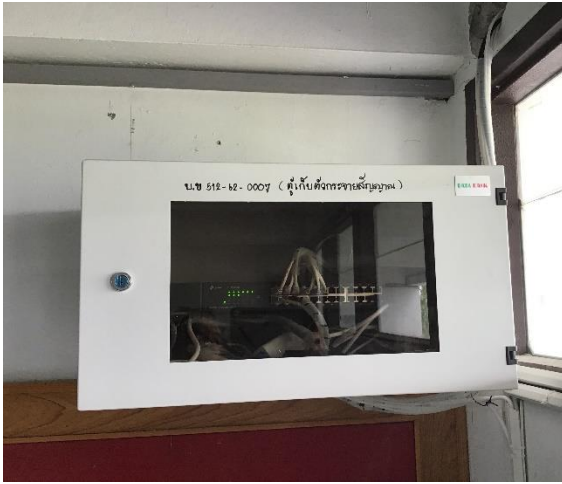
ภาพตู้แล็คที่ใช้ในการเชื่อมต่อระบบอินเทอร์เน็ตในอาคารเรียนต่างๆ
