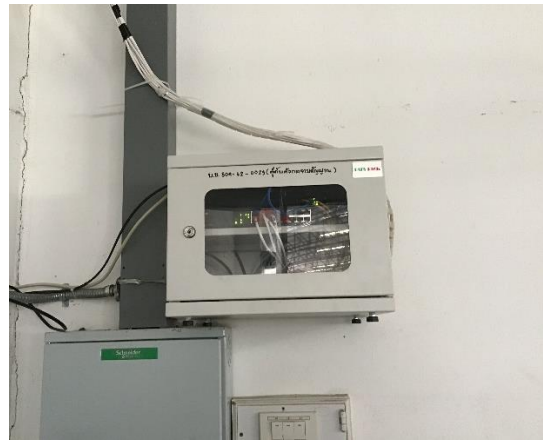
ภาพตู้แล็คที่ใช้ในการเชื่อมต่อระบบอินเทอร์เน็ตในอาคารเรียนต่างๆ
